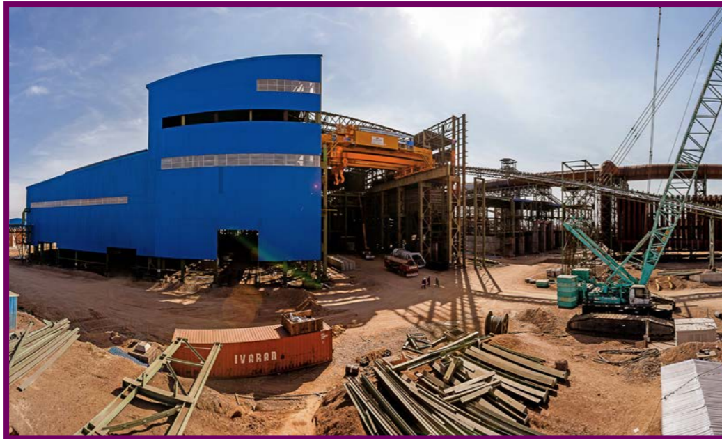
نمایی از سنگین بردار ۳۴۰ تنی حمل قراضه و سالن ذوب
