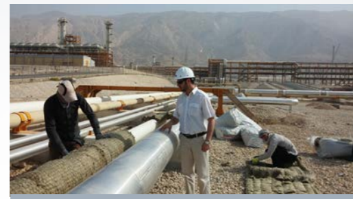
تصویر شماره ۴- عایق کاری خطوط لوله در پالایشگاه فاز ۱۷ و ۱۸
