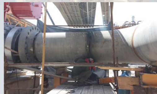
تصویر شماره ۱- جوشکاری پایپینگ در پالایشگاه فاز ۱۷ و ۱۸
