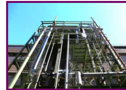
نمای بیرونی پروژه گاززدایی تحت خلا،
