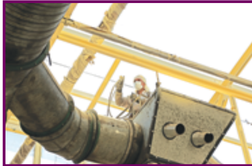
▲ رنگ آمیزی خرپا و سقف سالن
