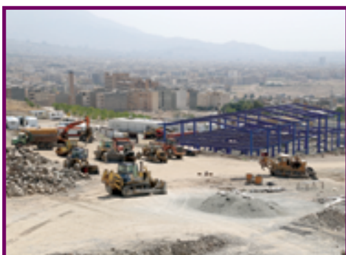
▲ نمای کلی از سایت پروژه
