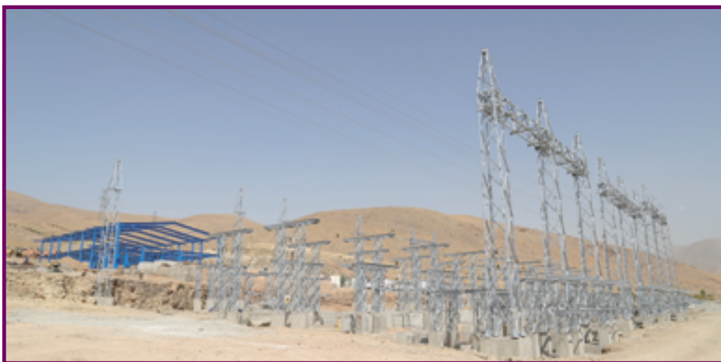
▲ نمای اسکلت فلزی تجهیزات بخش 63 kw و اسکلت فلزی ساختمان کنترل
