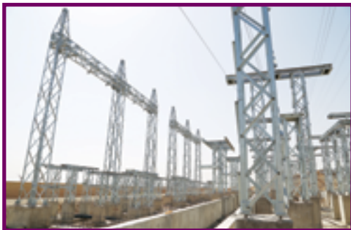
▲ نصب اسکلت فلزی تجهیزات بخش 63 kw
