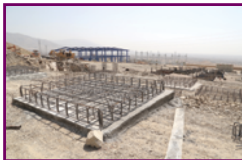
▲ فونداسیون تجهیزات بخش 400 kw
