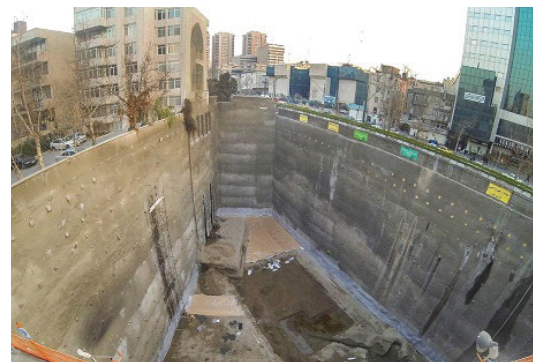
شکل ۲- گود برداری در زمین های محدود
