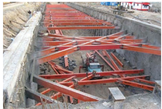
شکل ۳- نصب استرات در سازه های نگهدارنده
