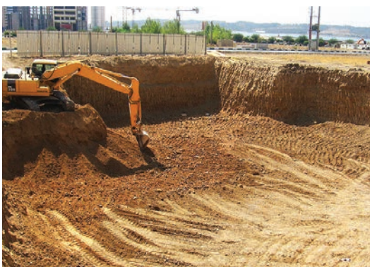
شکل (۱) - گودبرداری در زمین‌های نامحدود
