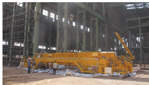
عملیات نصب جرثقیل حمل پاتیل های ذوب فولاد بردسیر - تام نامه / عکاس: مجتهد شکیبیا
