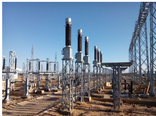
پست برق ۴۰۰/۱۳۲ کیلوولت جاجرم
