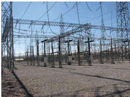
پست برق ۴۰۰ کیلوولت نیروگاه شیروان
