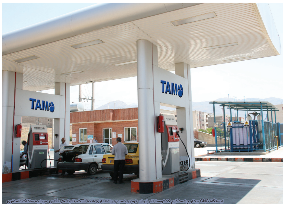
ایستگاه CNG بیدار چشمه کرج که توسط تام ایران خودرو نصب و راه اندازی شده است، تام نامه/عکاس: مریمیه سادات غفیری
