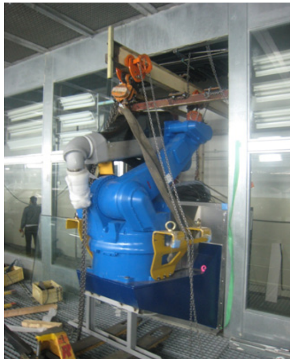
ربات در حال جابجایی روی خرک و انتقال به درون کابین
