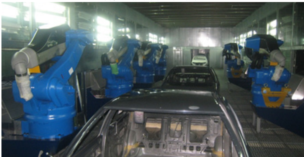
نمایی از ربات‌های نصب شده و کابین مونتاژ شده
