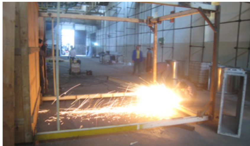
خرک در حال ساخت
