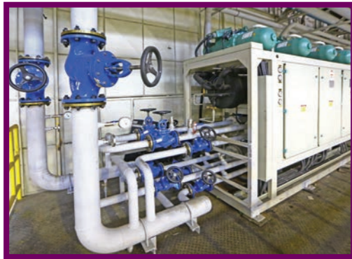
نصب و راه اندازی چیلر به ظرفیت اسمی ۱۶۰ تن
