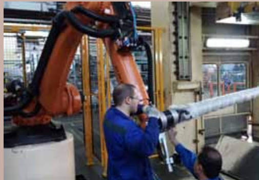
مرحله نصب و راه‌اندازی تجهیزات ربات‌های خط ۱-G2، تام/تامه/عکاس: محمدرضا نقابی
